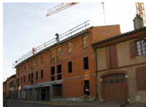
Les 14 logements en construction rue de la République.
